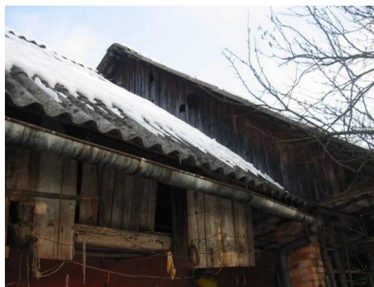
Slika 66: Ko so pozidali hlev, so streho hleva nekoliko dvignili nad streho stanovanjskega dela.
