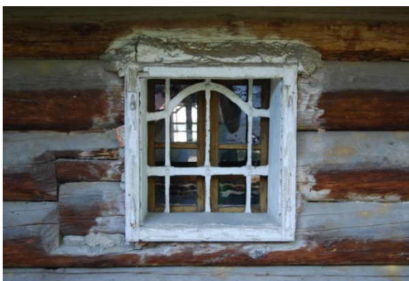
Slika 76: Prvotna okna so v okoli leta 1920 zamenjali za večja zastekljena okna z gavtri.
