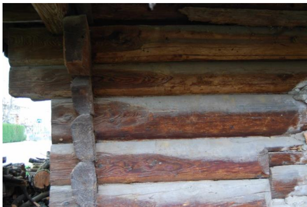
Slika 73: Na vogalih hiše na zahodni strani so polovična bruna zvezana z utori.
