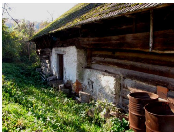
Slika 3: Na vzhodni strani je Gmajnarjeva domačija zidana v predelu črne kuhinje in krušne peči.
