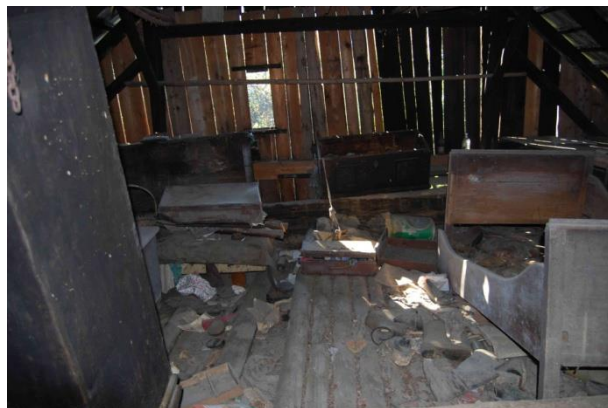
Slika 58: Pogled proti vzhodnemu delu podstrešja.
