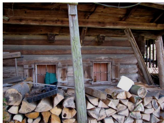
Slika 10: Pred okni v severni steni so zložena drva, ki imajo vlogo toplotne izolacije.
