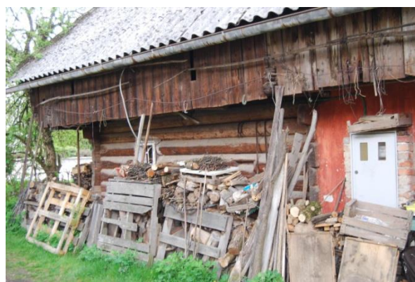
Slika 64: Pred stenami jugozahodnega dela domačije so naložena drva, ki služijo tudi za toplotno izolacijo.
