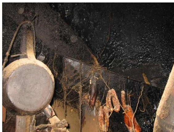
Slika 86: Nad kuriščem krušne peči je strop sajast, saj krušna peč nima dimnika, ampak se dim vali po črni kuhinji proti dimniku.
