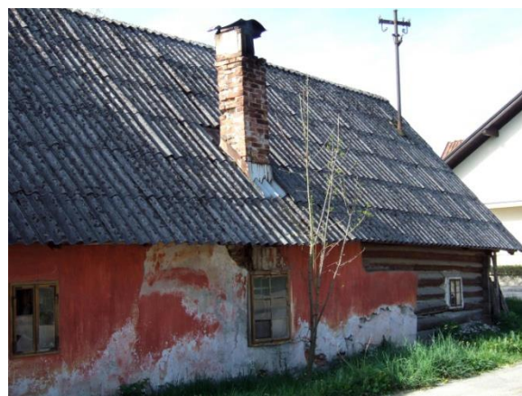
Slika 70: V predelu črne kuhinje in krušne peči je stanovanjski del hiše zidan.
