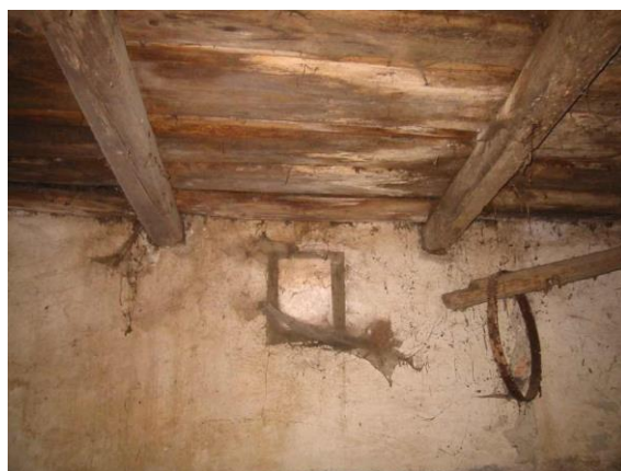
Slika 106: Strop v hlevu je že precej trhel. Pod stropom so nekoč vedno gnezdile lastovke.
