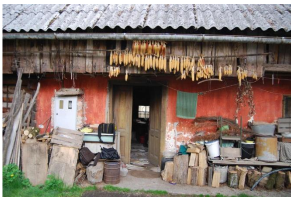
Slika 65: Vhod je z južne strani: najnovejša je omarica za električno energijo.
