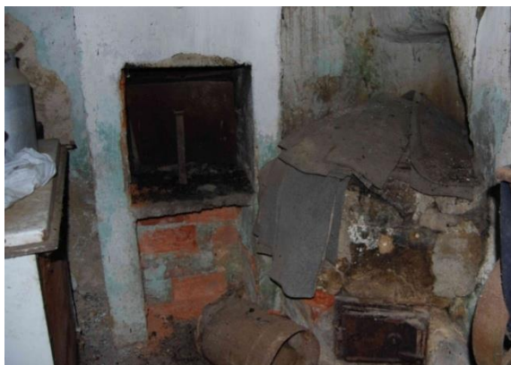
Slika 29: V kotu med kuriščem krušne peči in zunanjo steno domačije je stransko kurišče, na katerem so kuhali hrano za prašiče.
