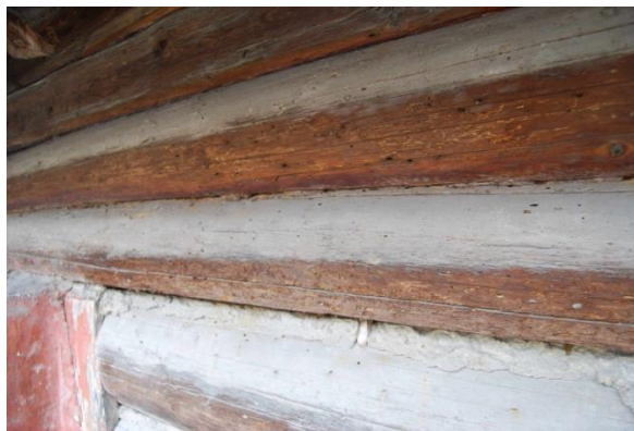
Slika 74: Razmaki med bruni so bili prvotno zatrpni z mahom, kasneje z malto. Kjer je mah, je les dobro ohranjen, kjer je malta, pa je les trhel.
