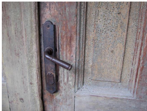
Slika 80: Stara kljuka in dvokrilna vhodna vrata.
