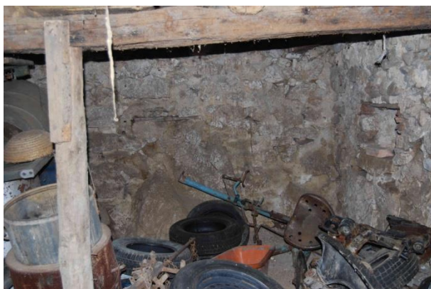
Slika 53: Pogled v kamnito klet pod kamro.
