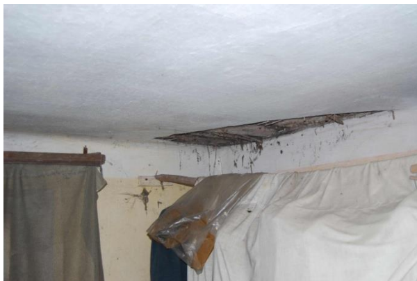
Slika 91: Strop v kamri na enem mestu odpada.
