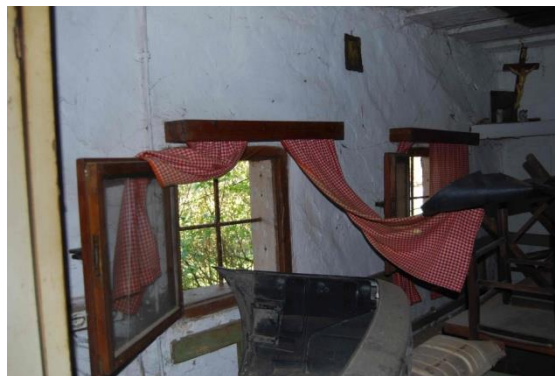
Slika 44: Prvotna okna na smuč so zamenjali s steklenimi, ki so se odpirala v štirih delih. Današnja, ki so bila vgrajena leta 1974, so enake velikosti.
