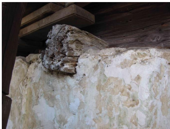
Slika 8: Stik zidanega dela hiše z lesenim ostrešjem.
