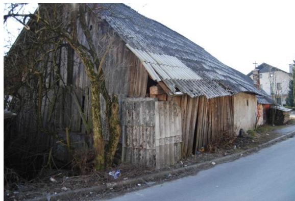
Slika 68: Severovzhodni del domačije se nekoliko poveša, čeprav so bili nosilni tramovi zamenjani.
