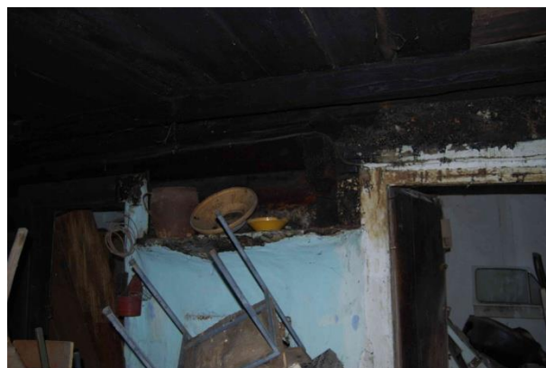
Slika 22: Nad kuriščem je zidana polica za lončeno kuhinjsko posodo. Ob straneh sta vhoda v štibelc in v kamro.
