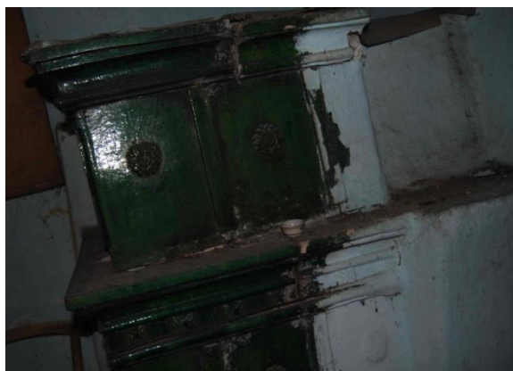
Slika 40: Za vrati je kmečka peč, ki ogreva predvsem štibelc, preko zidane stene pa tudi kamro.
