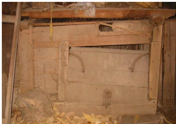
Slika 110: Svinjak ima več posebnosti: lina za kuhanje k prašičem, dvigajoča vrata in večja in manjša korita za krmljenje prašičev.
