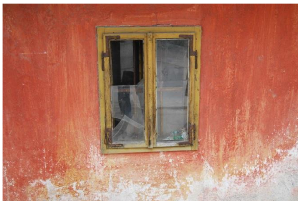
Slika 77: V kamri so vgrajena večja okna.
