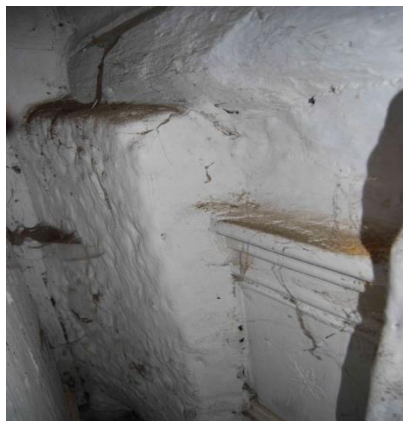
Slika 32: Za vrati kamre je stena zidana, ker je na drugi strani kmečka peč. Zid je oblikovan v nekakšne police.
