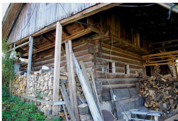
Slika 10: Pred okni v severni steni so zložena drva, ki imajo vlogo toplotne izolacije.
