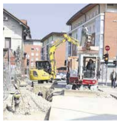
Obnova vodovoda in kanalizacije na Slamnikarski cesti
