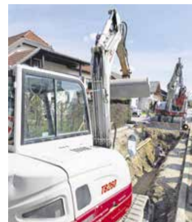
Obnova vodovodnega in kanalizacijskega omrežja
