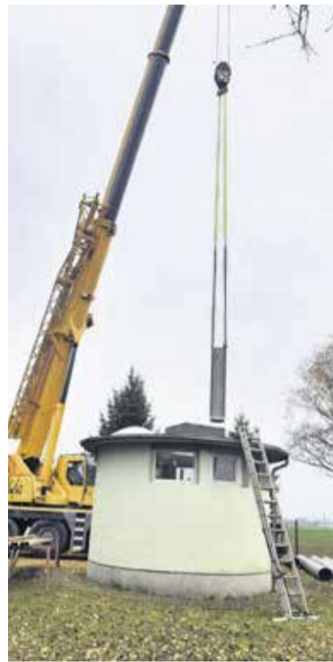
Sanacija vrtine vodnjaka Č3 na domžalsko-mengeškem polju
