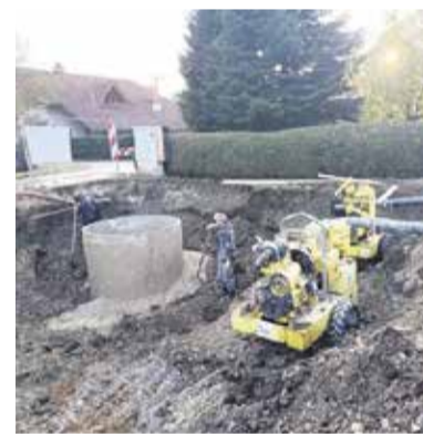
Dela na kanalizacijskem črpalnišču v Dragomlju
