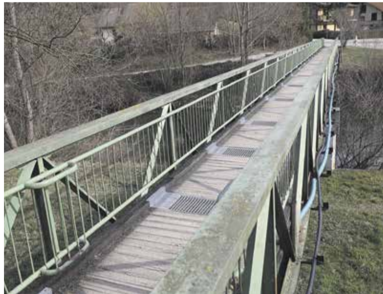
V času prenove mostu bo pešcem in kolesarjem omogočen prehod (Foto: Vido Repanšek)
