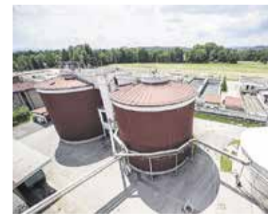
Centralna čistilna naprava Domžale - Kamnik
