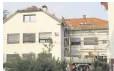
Streha na OŠ Dob je bila v celoti obnovljena.
