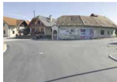
Prenovljeno vozišče in razširjeno križišče v Dragomlju
