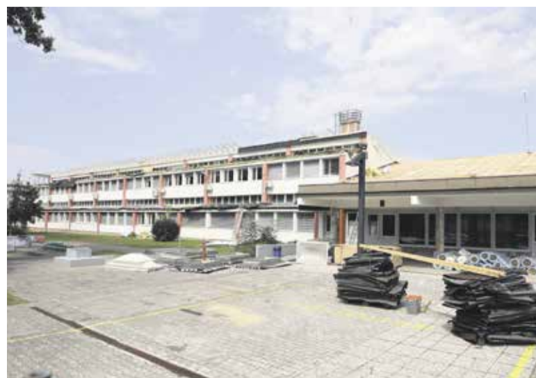
Prenova strehe na OŠ Preserje pri Radomljah
