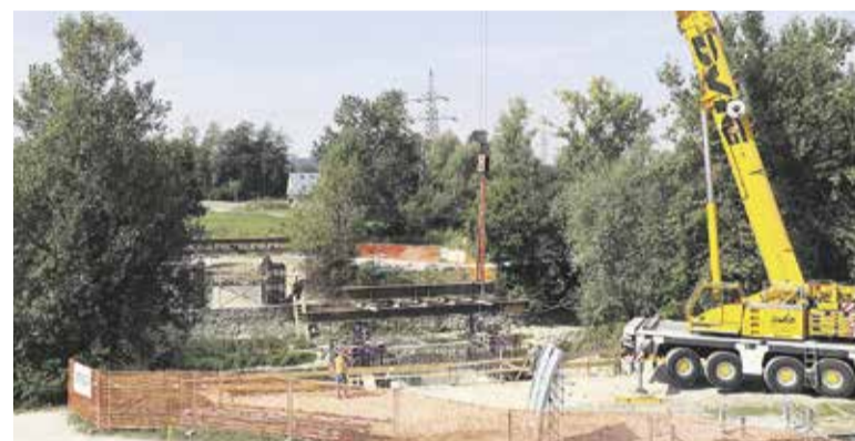
Gradnja novega mostu na Viru
