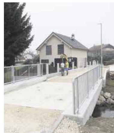
Dela na Študljanski cesti
