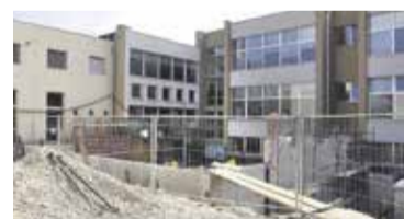
Dela na zahodnem delu prizidka – jedilnica, OŠ Rodica.
