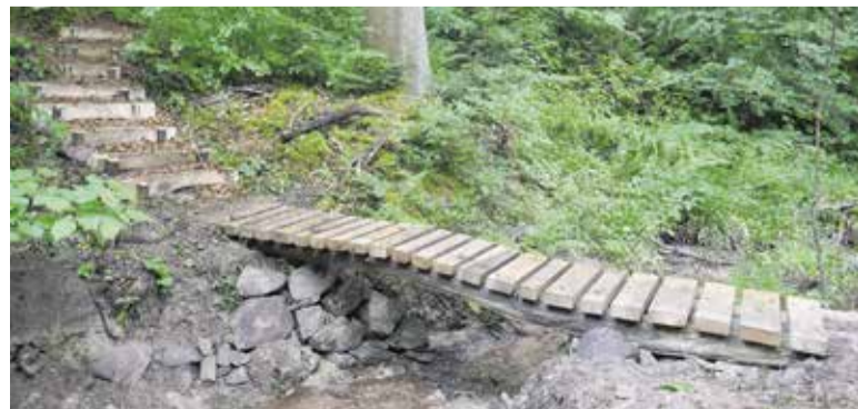
Novi mostiček v Kolovcu
