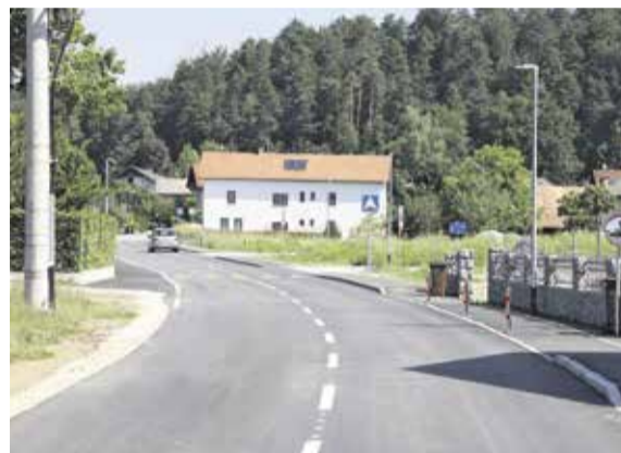
Zaključena je srednja etapa rekonstrukcije Opekarniške ceste.
