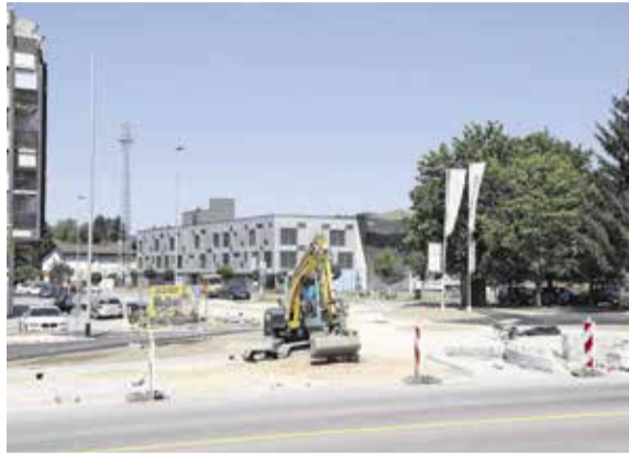
V središču mesta poteka gradnja enopasovnega krožišča.
