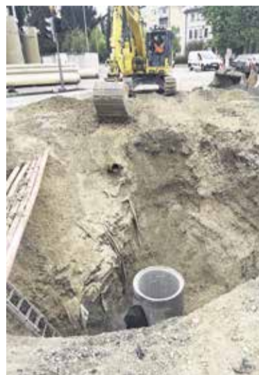
Obnova kanalizacije ob gradnji krožišča Ljubljanska-Kamniška
