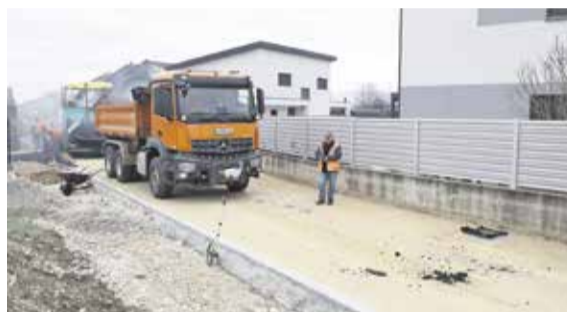
Asfaltiranje Gajeve ulice v Preserjah pri Radomljah
