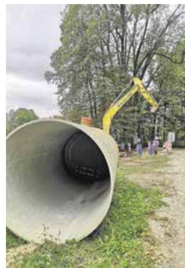
Jašek kanalizacijskega črpališča v Mali Loki
