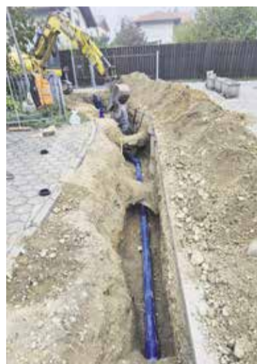
Obnova vodovoda na Aškerčevi ulici v Domžalah
