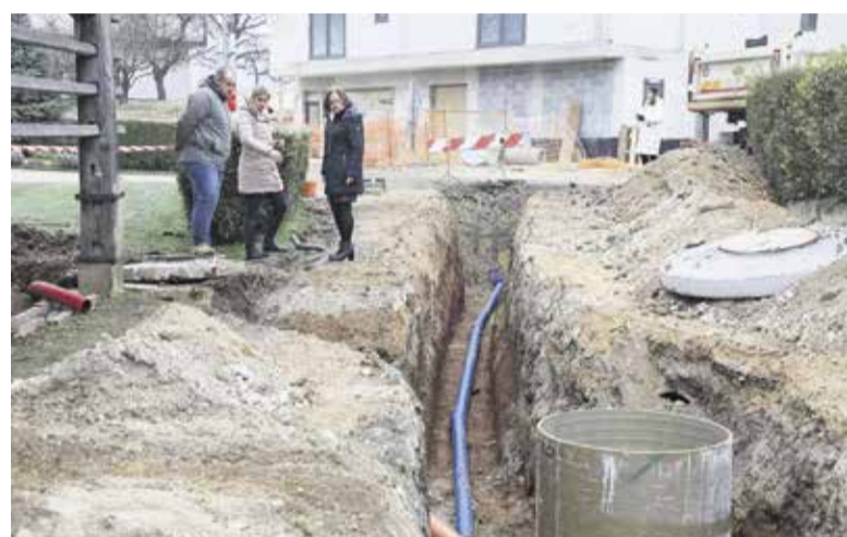
Gradnja kanalizacije in vodovoda v Škocjanu
