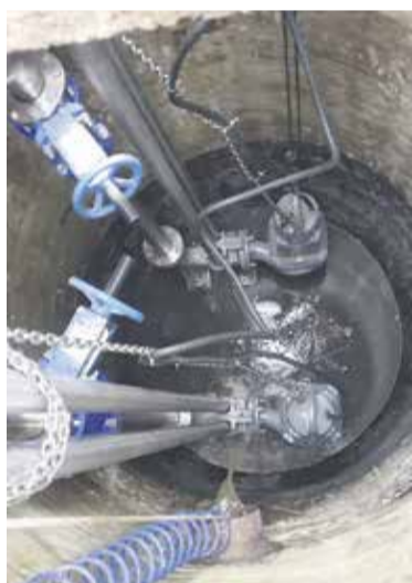
Kanalizacijsko črpališče Škrjančevo, kjer sta bili zamenjani črpalčki, ki prečrpavata odpadno vodo na višji nivo, da odpadna gravitacijsko odteka proti čistilni napravi.
