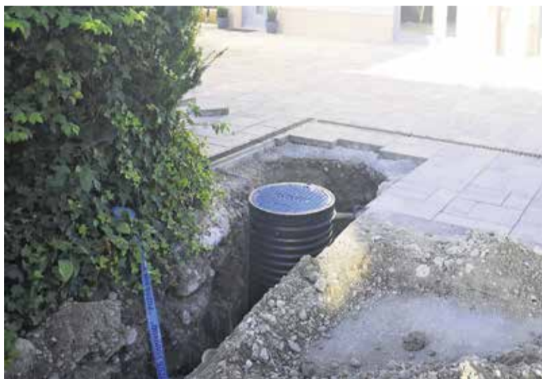
Ob obnovi vodovoda se obnavlja tudi vodovodne hišne priključke.
