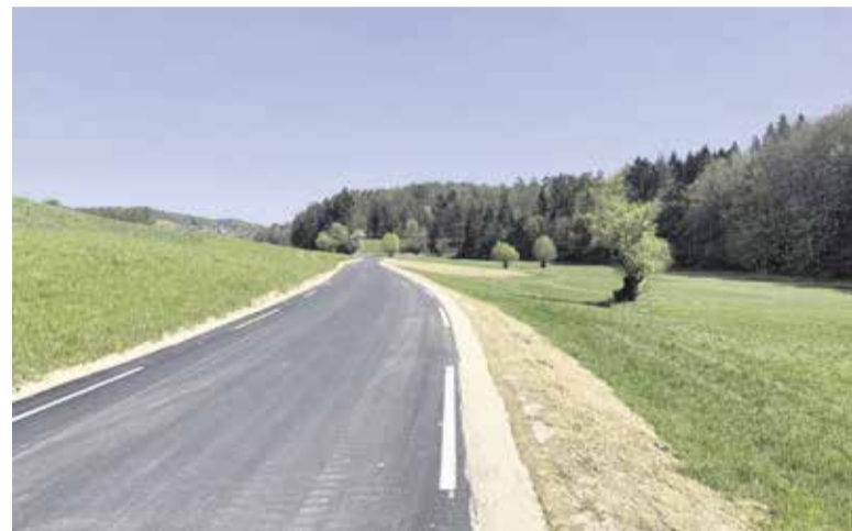
Prenovljena cesta Rova–Dolenje
