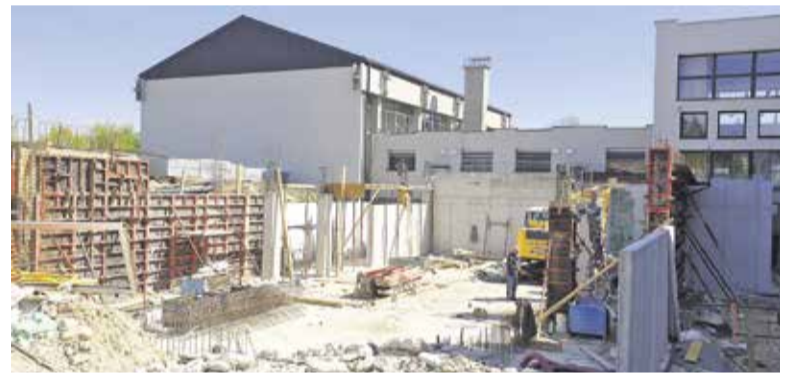
Betoniranje sten
