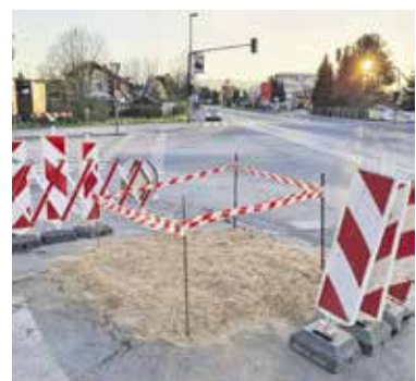
Zavarovan del poti med posegom
