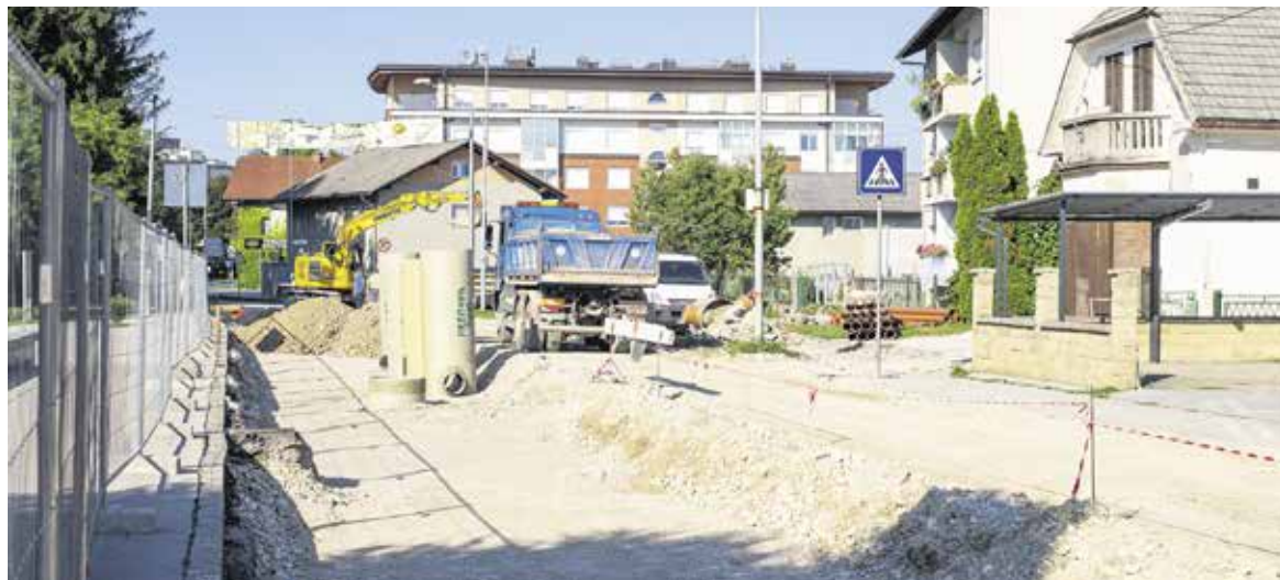
Obnova vodovodnih priključkov
