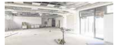
Sledi še montaža opreme.
