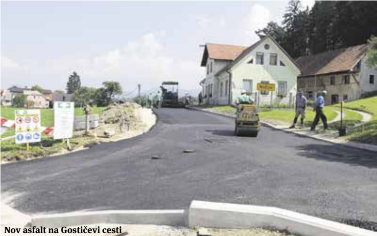
Nov asfalt na Gostičevi cesti
