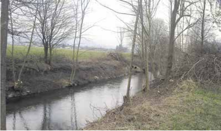
Potok Rača po sanaciji
