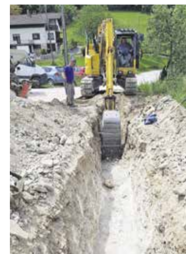
Zamenjava vodovoda v Kokošnjah
