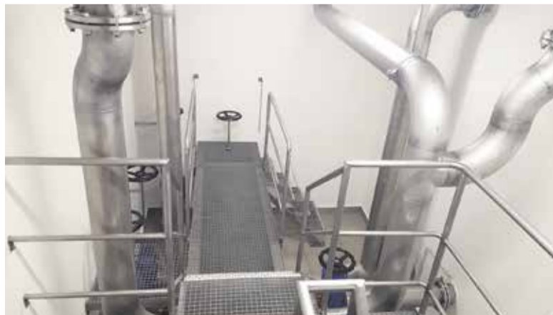
Obnovljena notranjost vodohrana 2
