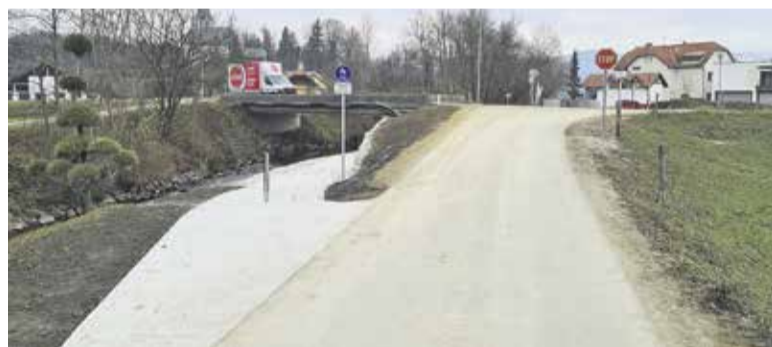
Nov podhod na Krtini omogoča večjo prometno varnost.
