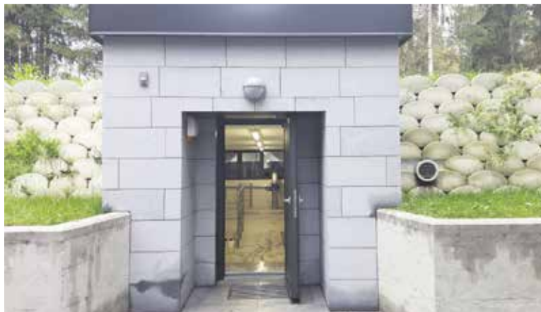
Obnovljeni vodohran Šumberk 2 skupaj z vodohranom Šumberk 1 hrani dva milijona litrov čiste pitne vode za Trzin in Domžale.
