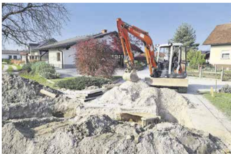
Obnova vodovoda na Gostičevi ulici
