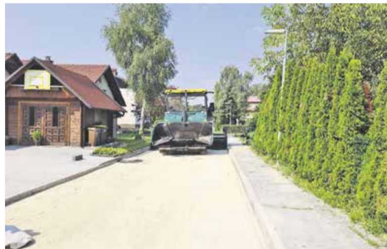
Utrjevanje cestne površine po izvedeni obnovi vodovoda na Kersnikovi ulici v Dobu
