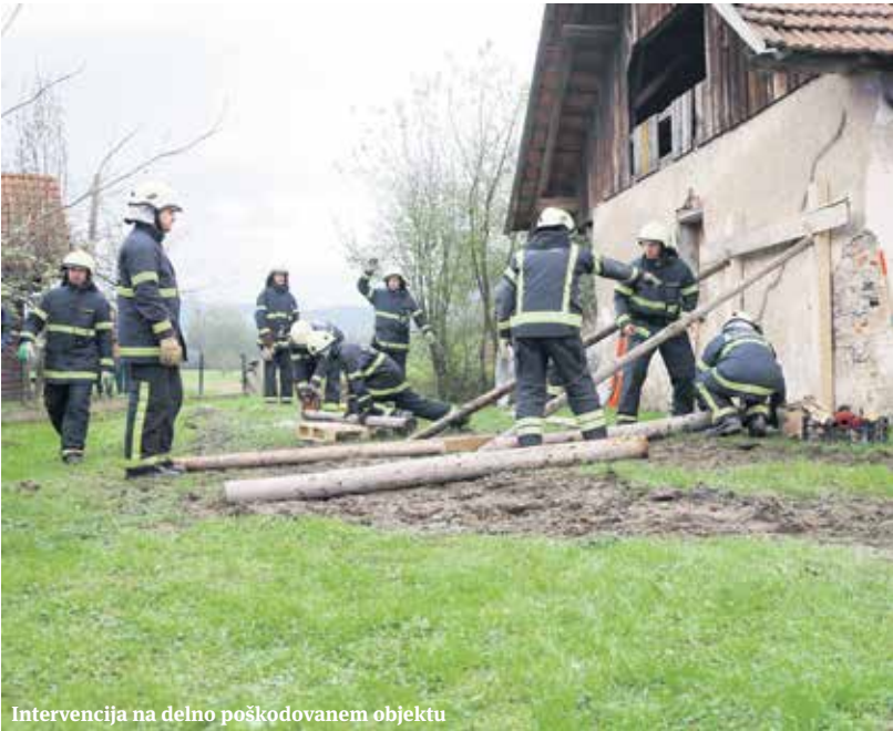
Intervencija na delno poškodovanem objektu
