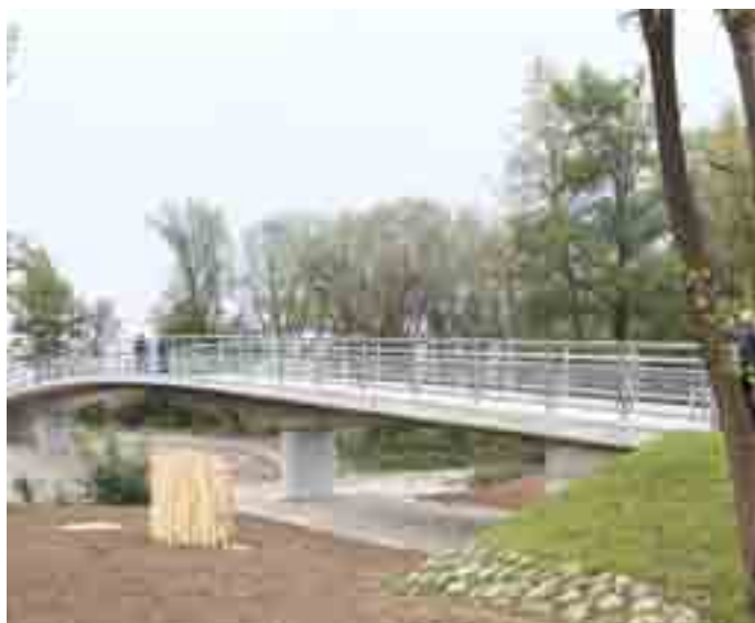
Novozgrajeni most Gaj na Škrjančevem
