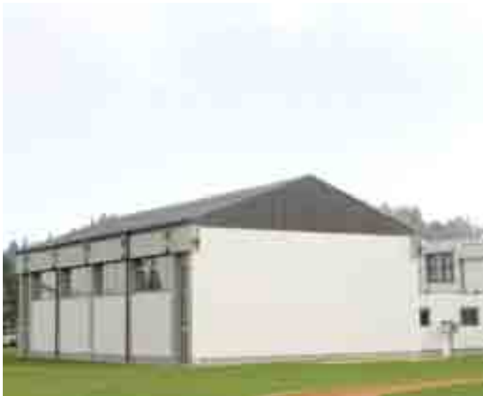
Energetska sanacija OŠ Domžale
