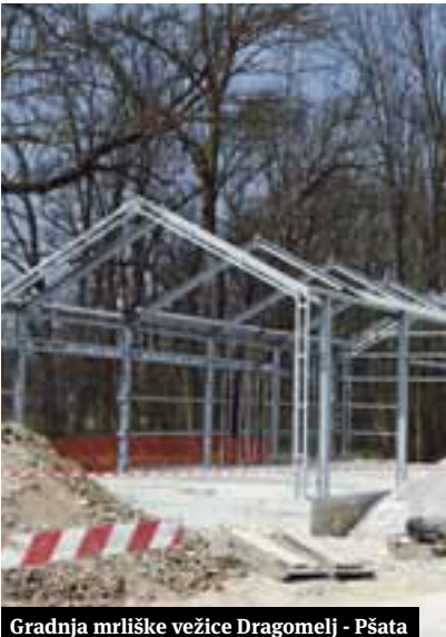
Gradnja mrliške vežice Dragomelj - Pšata
