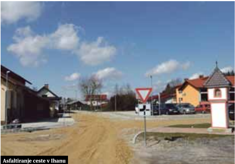
Asfaltiranje ceste v Ihanu
