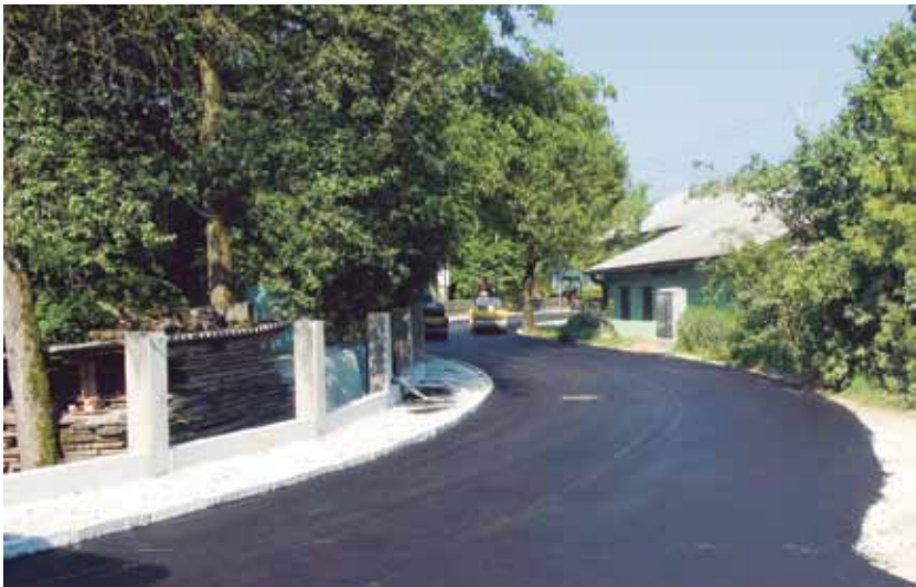
Rekonstrukcija ceste v Študi
