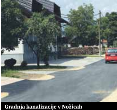
Gradnja kanalizacije v Nožicah
