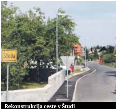
Rekonstrukcija ceste v Študi
