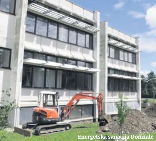
Energetska sanacija Domžale
