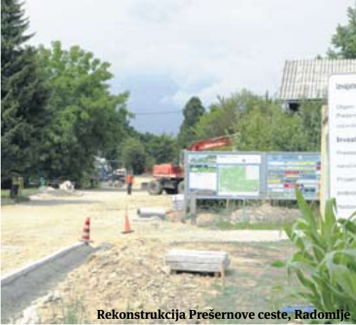
Rekonstrukcija Prešernove ceste, Radomlje
