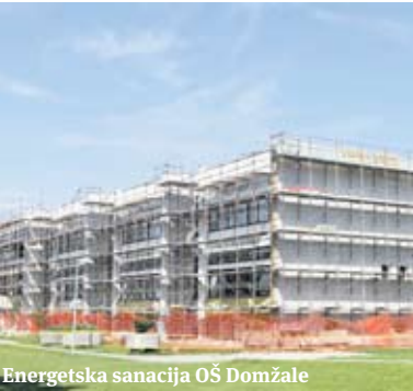
Energetska sanacija OŠ Domžale
