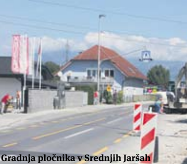
Gradnja pločnika v Srednjih Jaršah
