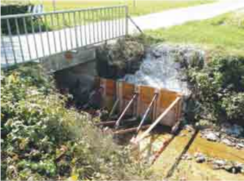
Sanacija brežine ob mostu v Dobu
