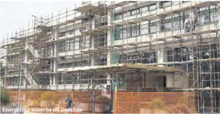
Energetska sanacija OŠ Domžale
