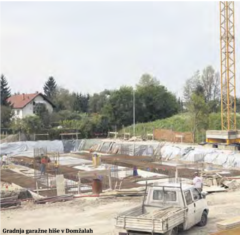
Gradnja garažne hiše v Domžalah
