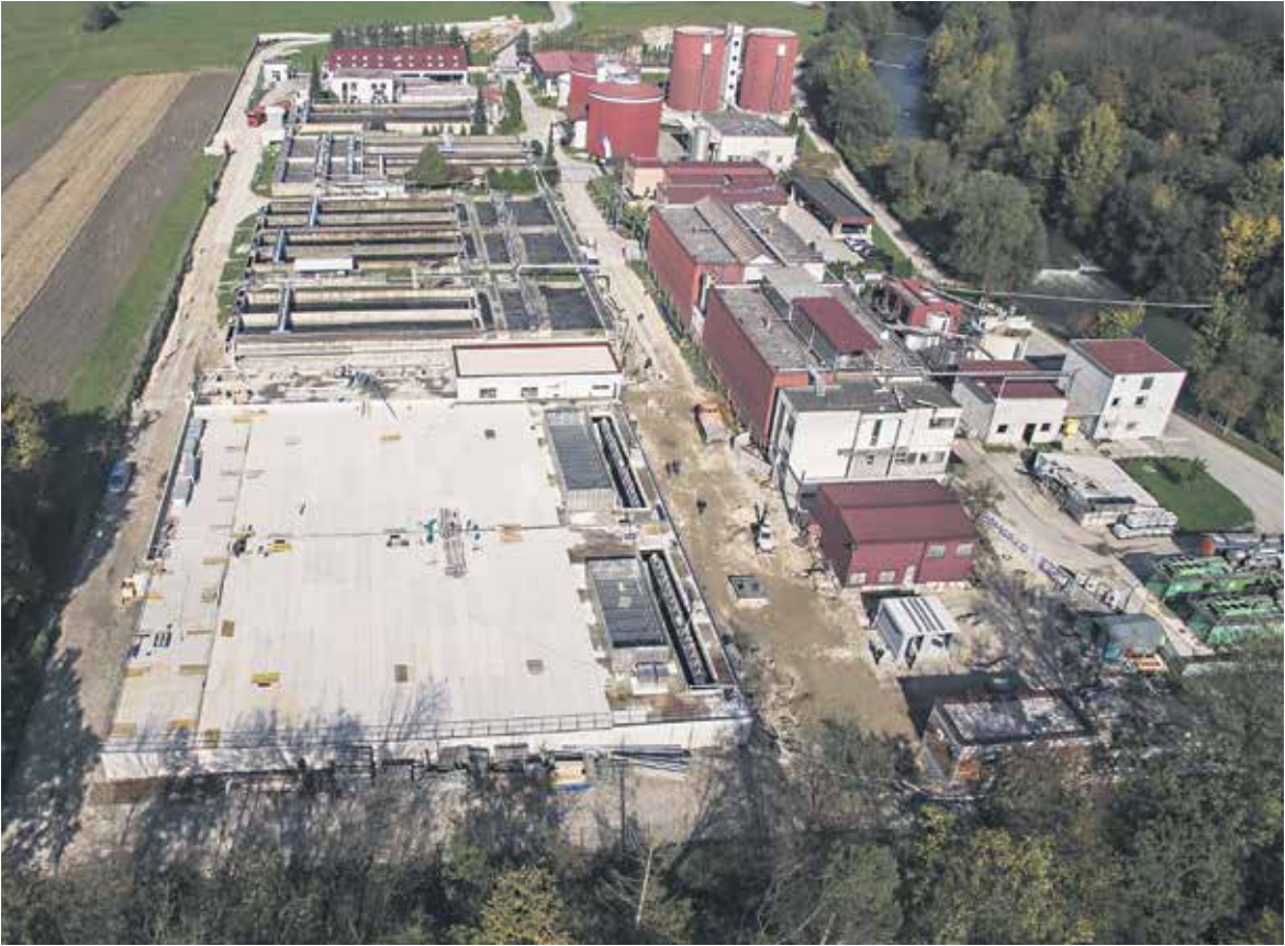
Izvajanje nadgradnje CČN, oktober 2015.
