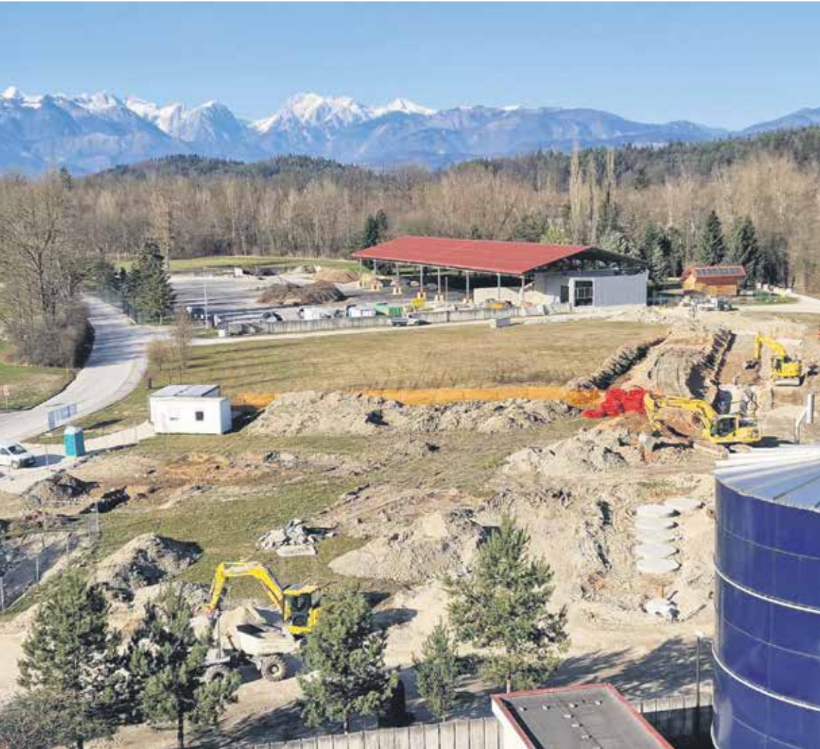
Začetek gradnje novega objekta za sušenje blata, ki ga je za CČN Domžale - Kamnik izvajalo ljubljansko gradbeno podjetje RIKO.
