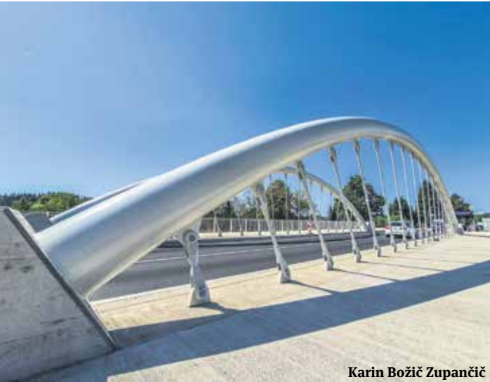
Rehabilitacija mostu čez Kamniško Bistrico
