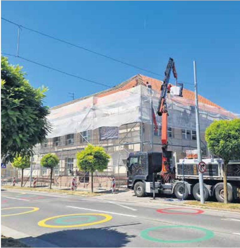
Obnova strehe na Domžalskem domu
