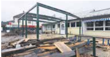
Pri Vrtcu Urša je gradbišče ustrezno ločeno od vzgojno-izobraževalnega dela.
